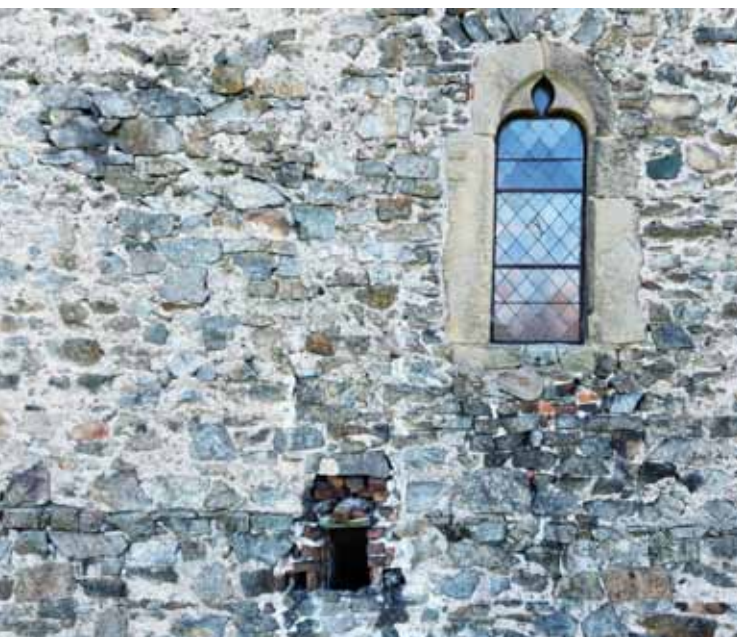
Widok na ścianę północną wieży. W dolnej części widoczny wylot kanału dymowego z kominka oraz gniazda po belkach, na których wznosiła się konstrukcja kominu (fot. M. Gmur)
