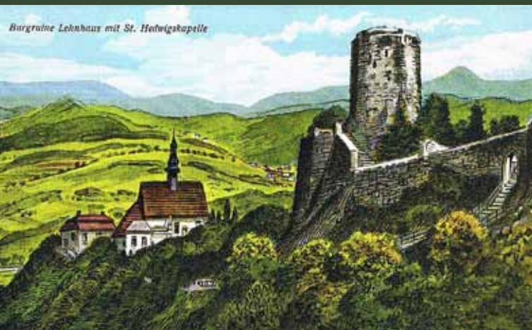
Widok na ruiny zamku, kościół św. Jadwigi i belweder. U dołu, w środkowej części, widoczny Balkon św. Jadwigi (archiwalna pocztówka z początku XX wieku)
